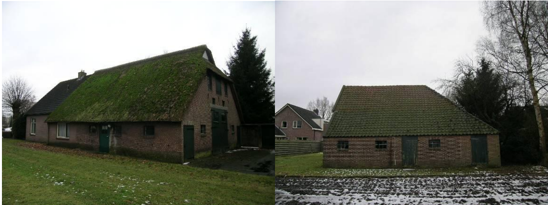
Foto 1 en 2: Het woonhuis en de schuur.
