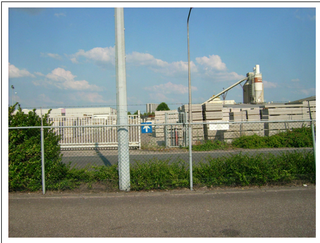
Foto 5. Omgeving onderzoekslocatie, industrieterrein.
