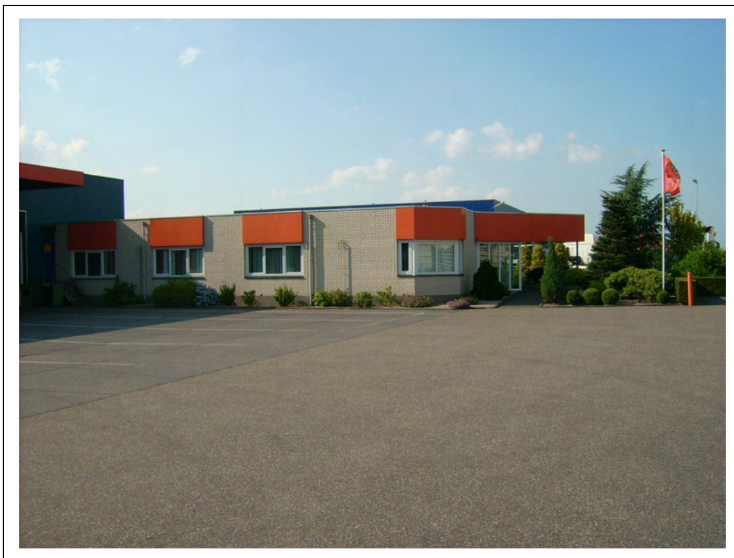
Foto 2. Kantoorgebouw met stootvoegen, na inspectie ongeschikt gebleken voor vlermuizen.
