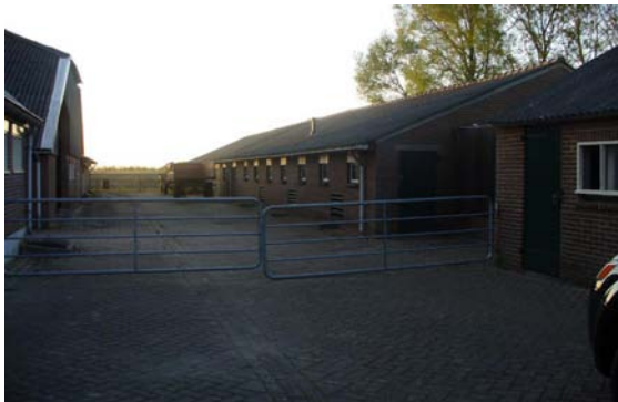
Figuur 4: Te slopen schuren met links de kapschuur en rechts de oude varkensschuur
