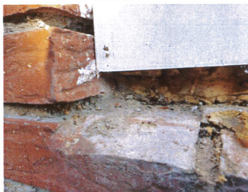
destructief onderzoek spouwmuren
