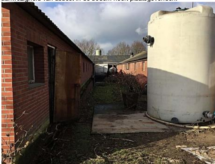
Figuur 2: Foto vanaf opslag spuiwater richting luchtwasser met links onverharde druppelzone die niet is onderzocht.
