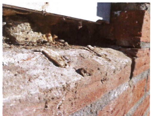
destructief onderzoek spouwmuren
