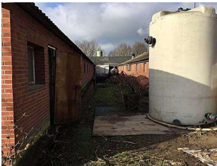
Figuur 1: Foto uit verkennend bodemonderzoek. Kijkpunt vanaf opslag spuiwater richting luchtwater met links onverharde druppelzone van zuidelijke stal die niet is onderzocht.
