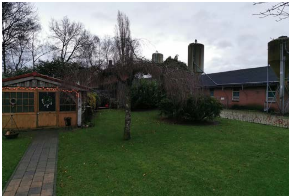
Figuur 3. Foto genomen vanuit de tuin bij de bedrijfswoning op de te slopen varkensstallen
