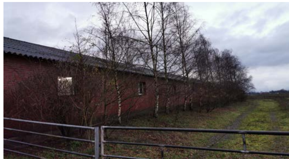
Figuur 11. De te slopen schuren.
