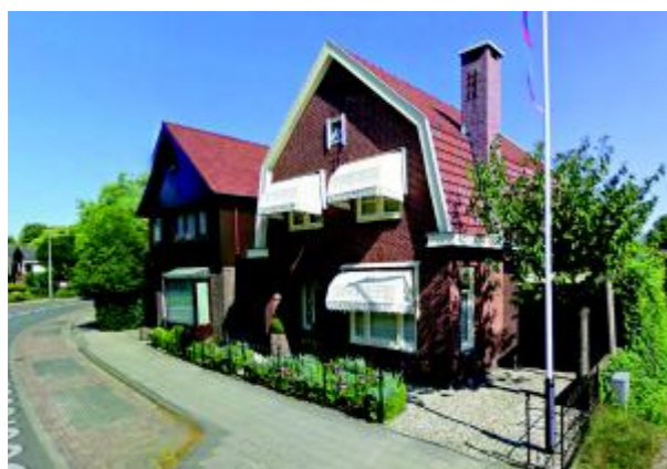
Zicht op de belendende bebouwing aan de Goorsestraat van het centrum af.
