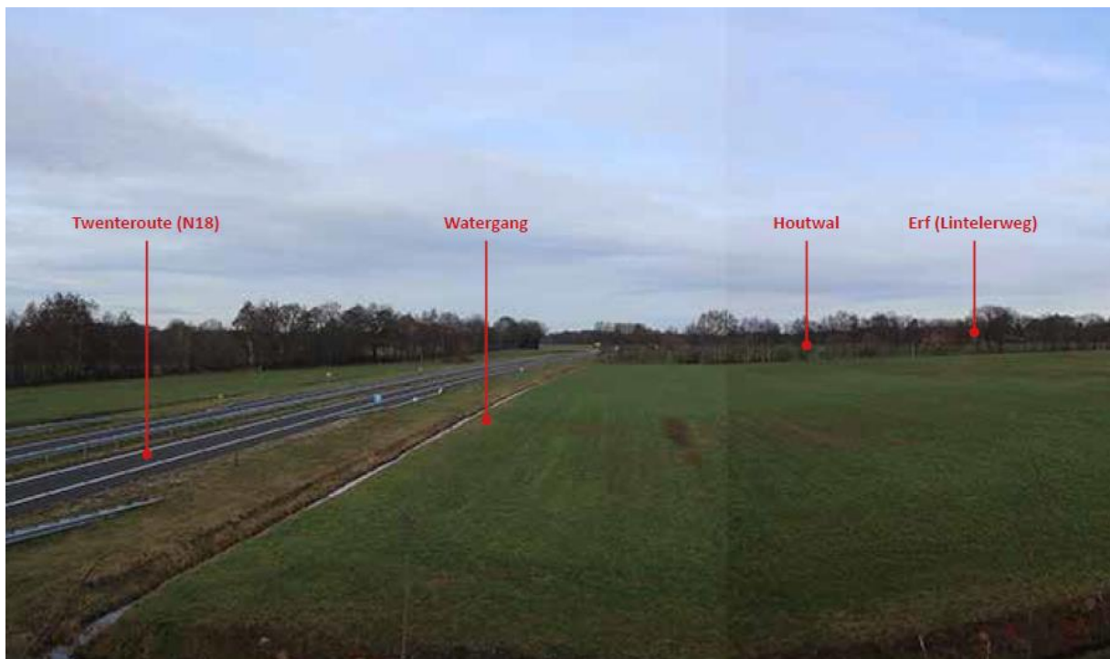
Figuur 10: Foto projectgebied: zicht vanaf het viaduct Kerkweg naar de noordkant van het projectgebied
