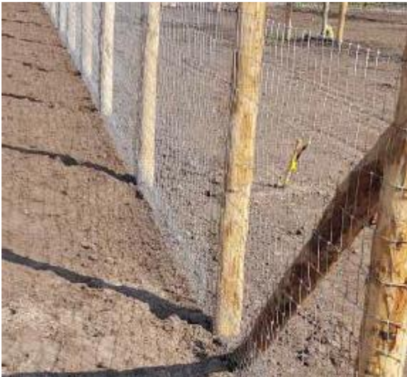
Figuur 15: Referentiebeeld van een landschappelijke hekwerk. De onderste 20 cm wordt opengehouden voor klein wild
