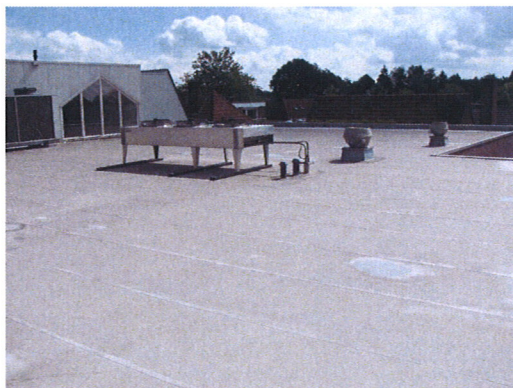
Overzichtsfoto van het dak.
