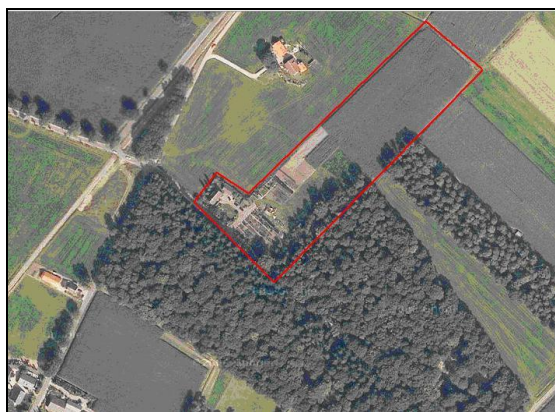
Figuur 10: Luchtfoto Hazenweg 14 (2004)
