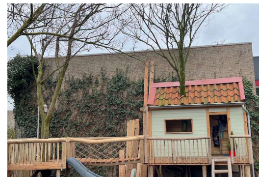
Figuur 14. Achterkant van het complex.
