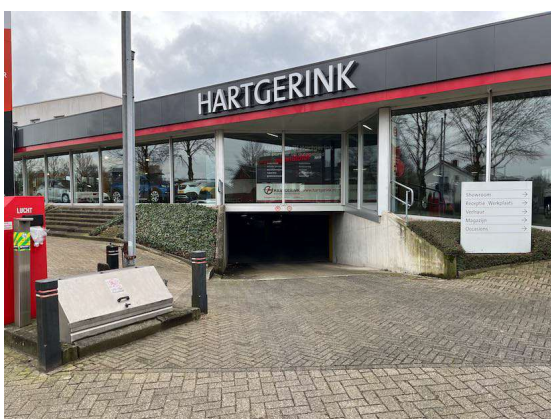
Figuur 6. Centrale voorgevel noordzijde.
