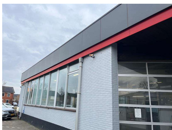
Figuur 8. Noordwesthoek werkplaats .
