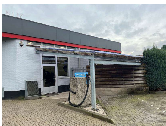
Figuur 9. Zuidwesthoek werkplaats.
