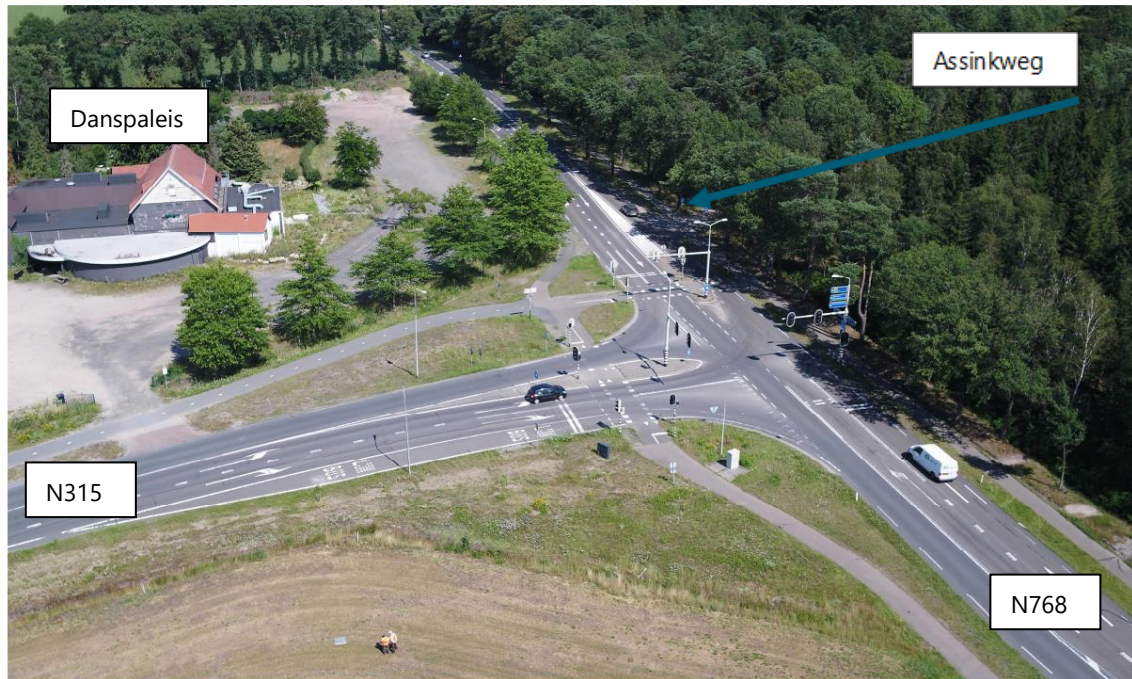
Afbeelding 1.2 luchtfoto van het bestaande kruispunt
