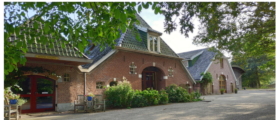
Afbeelding 20. Gevelgroen bepaalt de sfeer tussen de gebouwen
