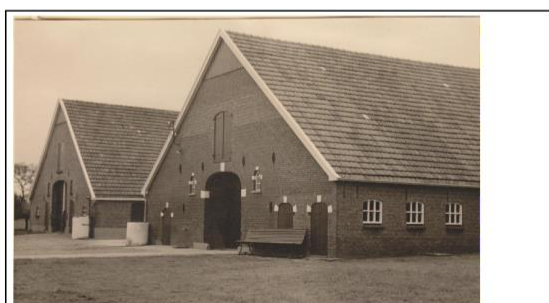
De beide stalgebouwen in de jaren 50-60 van de 20 ste eeuw. Het rechter bouwwerk heeft nog de oudere kern van het hallenhuis uit circa 1850, van het linker bouwwerk is dit niet bekend.
