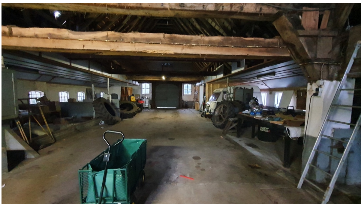
De gebintconstructie waarvan bij een aanpassing in 1966 de meeste standbenen werden opgevangen door een staalconstructie en hieronder werden afgezaagd.
