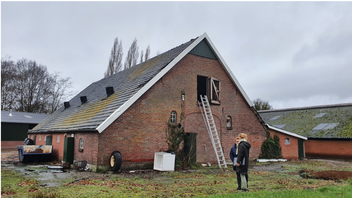
Zicht op het tweede stalgebouw vanaf het grasland.
