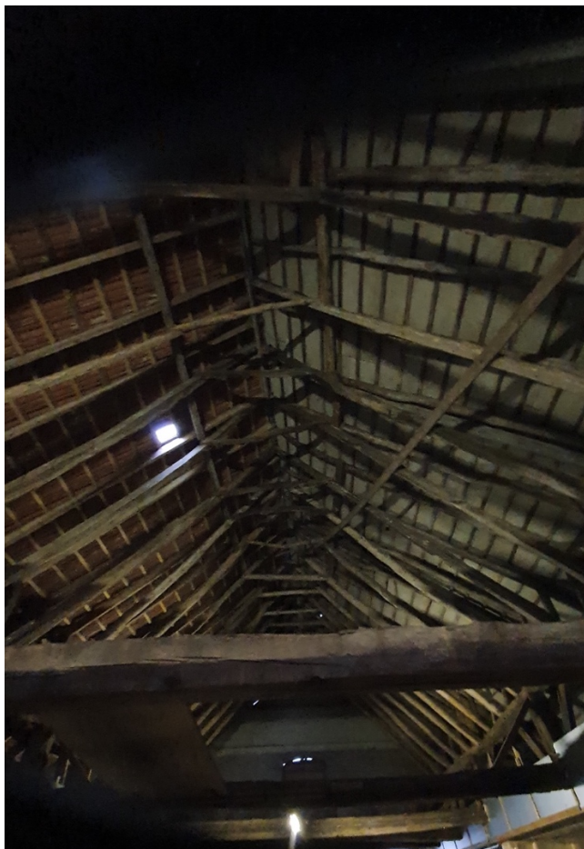
De afgeschoorde sporenkap met hanebalken.
