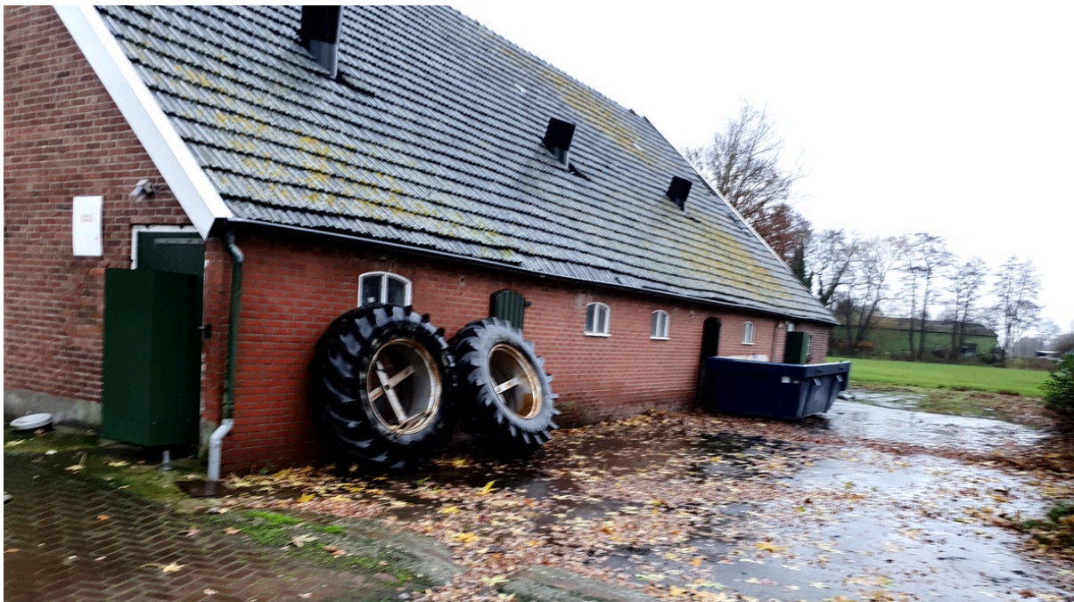
De vernieuwde zijgevel van hetzelfde stalgebouw.
