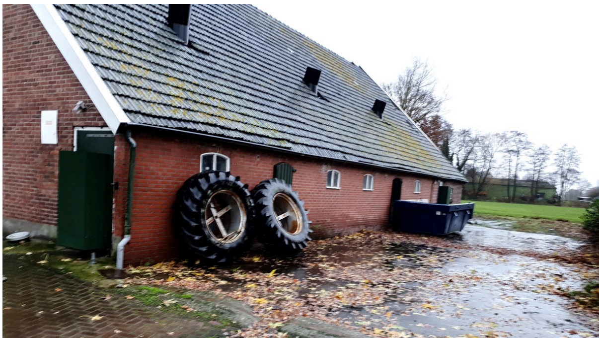
De vernieuwde zijgevel van hetzelfde stalgebouw.
