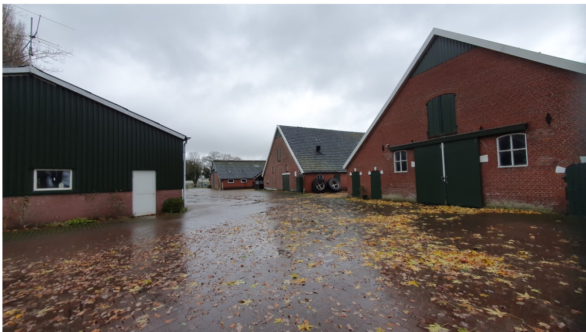
Het erf met links de schuur aan de weg en rechts de oorspronkelijke boerderij met een nieuwe schil, in de huidige situatie stalgebouw. In het midden het tweede stalgebouw dat in later in de 19 de eeuw is opgericht, maar ook in verschijningsvorm is aangepast. In het midden achterin het stalgebouw uit circa 1990.
