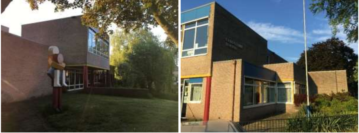
Detailopname van de te slopen bebouwing welke onderzocht is op de aanwezigheid van een verblijfplaats van vleermuizen.
