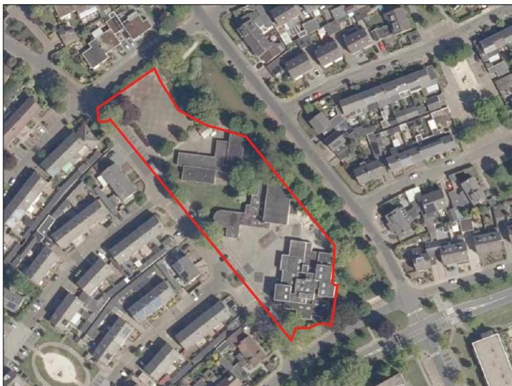
Afbeelding 2.1 Luchtfoto bestaande situatie plangebied (Bron: PDOK)
