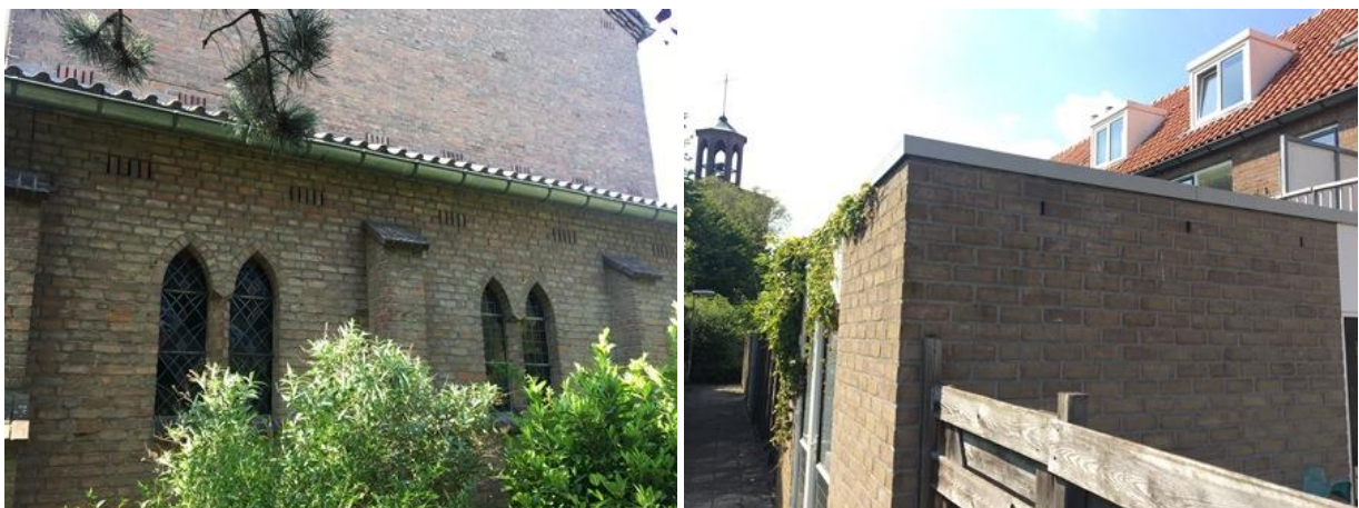
Openingen in de buitengevels van de gebouwen bieden vleermuizen de kans een verblijfplaats te bezetten in de spouw.
