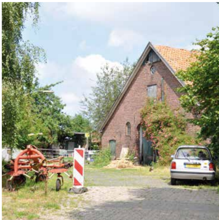
Erf aan de noordzijde van de Hassinkbrinkweg met een verwaarloosde aanblik..
