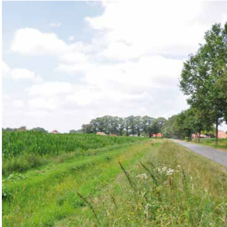
De Bolscherbeek heeft een technisch profiel met steile taluds inclusief maaipad. Op de achtergrond de eikenbeplanting van de Hassinkbrinkweg 24
