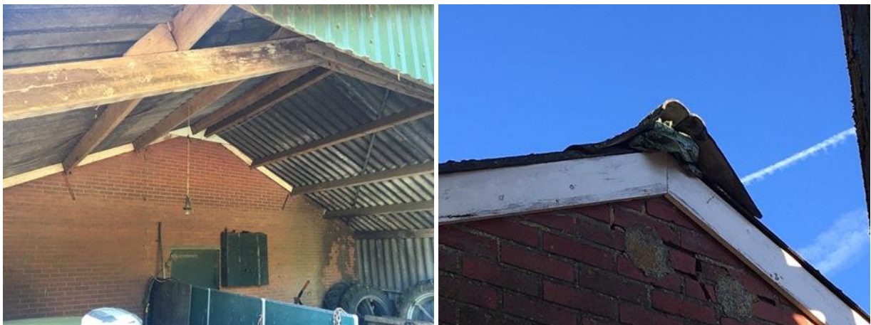
Foto links: potentiële broedplaats voor verschillende vogelsoorten. Foto rechts: gaten in het gebouw zijn dicht gemaakt om te voorkomen dat vogels onder de golfplaten gaan nestelen.
