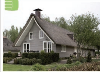
Goed voorbeeld van nieuwe burgerwoning met traditionele vormgeving en kleur- en materiaalgebruik. Gebruik van streekeigen details wordt hierbij aanbevolen.
