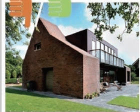
Geen goede interpretatie van traditionele vormgeving. Zogenaamde dakopbouw is te fors/overheersend en geeft te stedelijk beeld. Wel goede verwijzing naar oorspronkelijke kapvorm.
