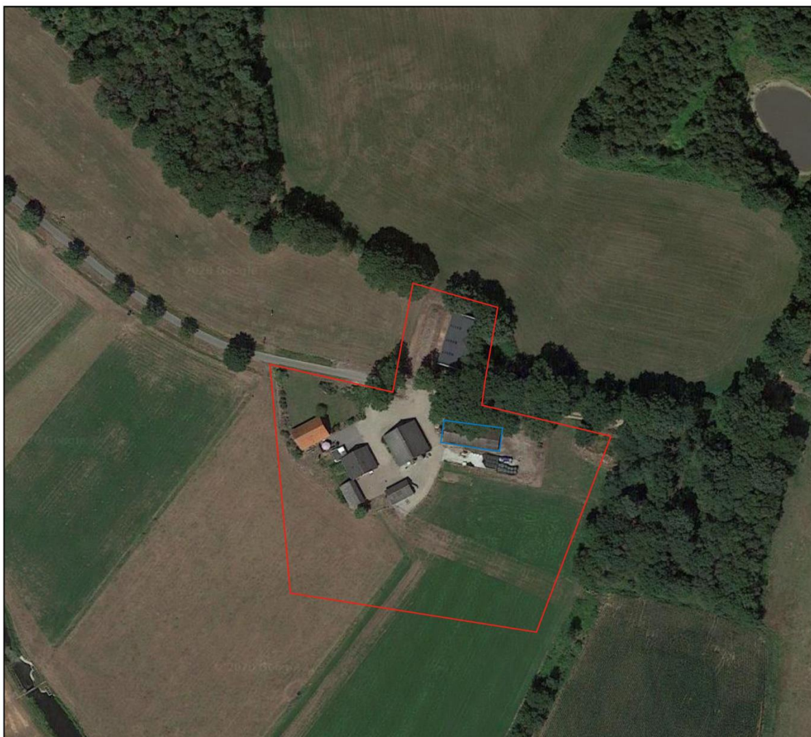
Afbeelding 2.5 Luchtfoto van de slooplocatie Spanjaardweg 16 (Bron: Google Maps)
