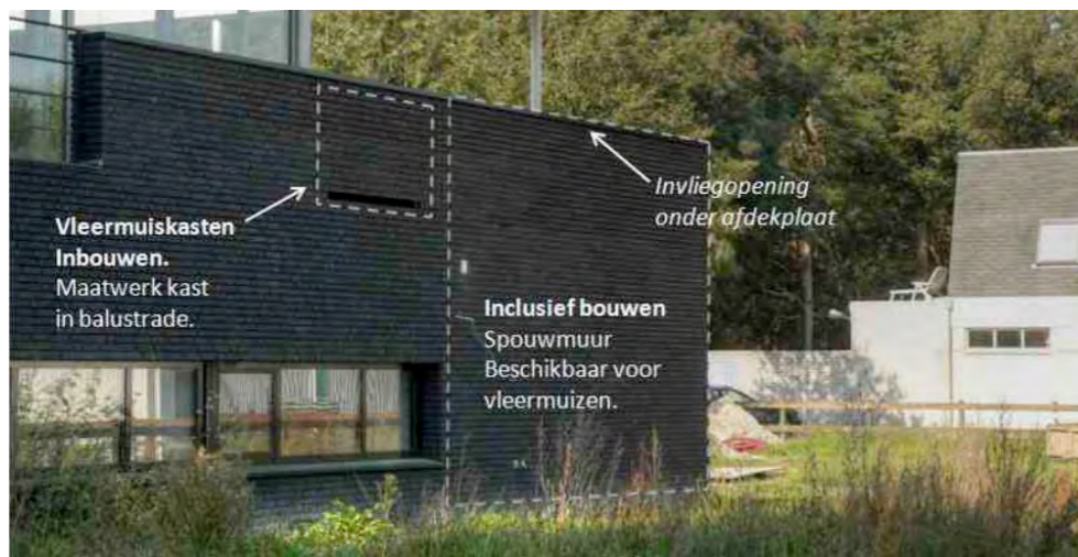
Afbeelding 57. Natuurinclusief bouwen: mogelijkheden integreren vleermuisvoorziening in gevels.
