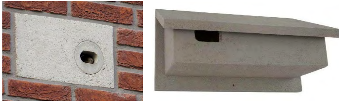
Afbeelding 54. Voorzieningen voor gierzwaluwen in en aan de gevel met smalle invliegopeningen.
