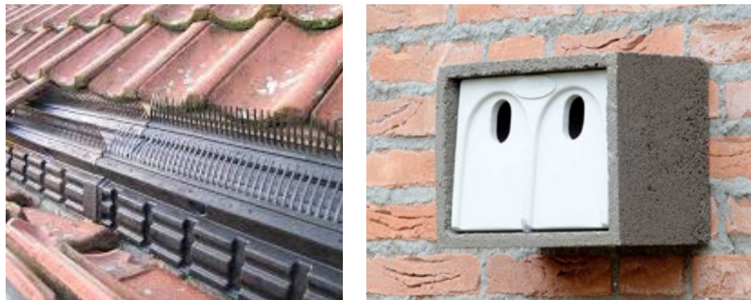
Afbeelding 55. Voorzieningen voor huismus: vogelschroten één pannenrij hoger toepassen en huismuskast.
