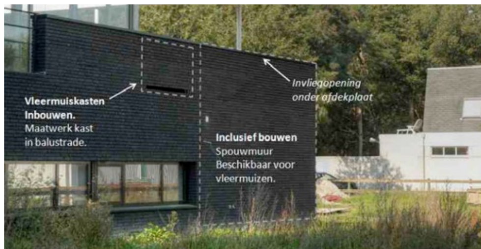
Afbeelding 57. Natuurinclusief bouwen: mogelijkheden integreren vleermuisvoorziening in gevels.
