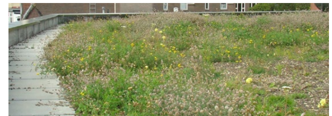
Afbeelding 58. Toepassing groen dak met kruidenmengsel: verhoogde biodiversiteit en waterbuffering.
