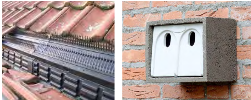
Afbeelding 53. Voorzieningen voor huismus: vogelschroten één pannenrij hoger toepassen en huismuskast.
