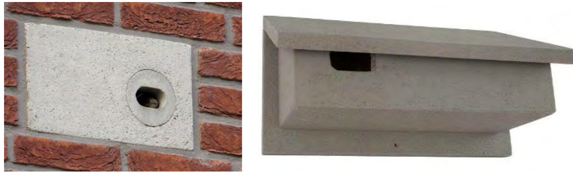
Afbeelding 52. Voorzieningen voor gierzwaluwen in en aan de gevel met smalle invliegopeningen.
