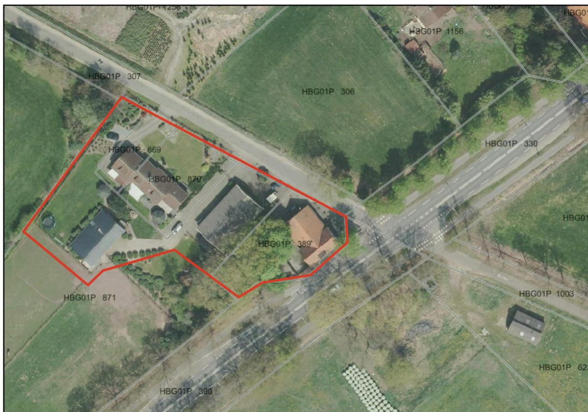
Afbeelding 2.1 Luchtfoto locatie Enschedesestraat 215 – Hazenweg 1/1a (Bron: Provincie Overijssel)
