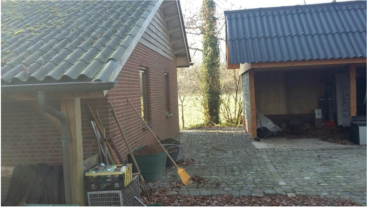
Aanzicht achterzijde schuur
