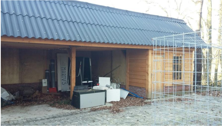
Aanzicht voorzijde kapschuur
