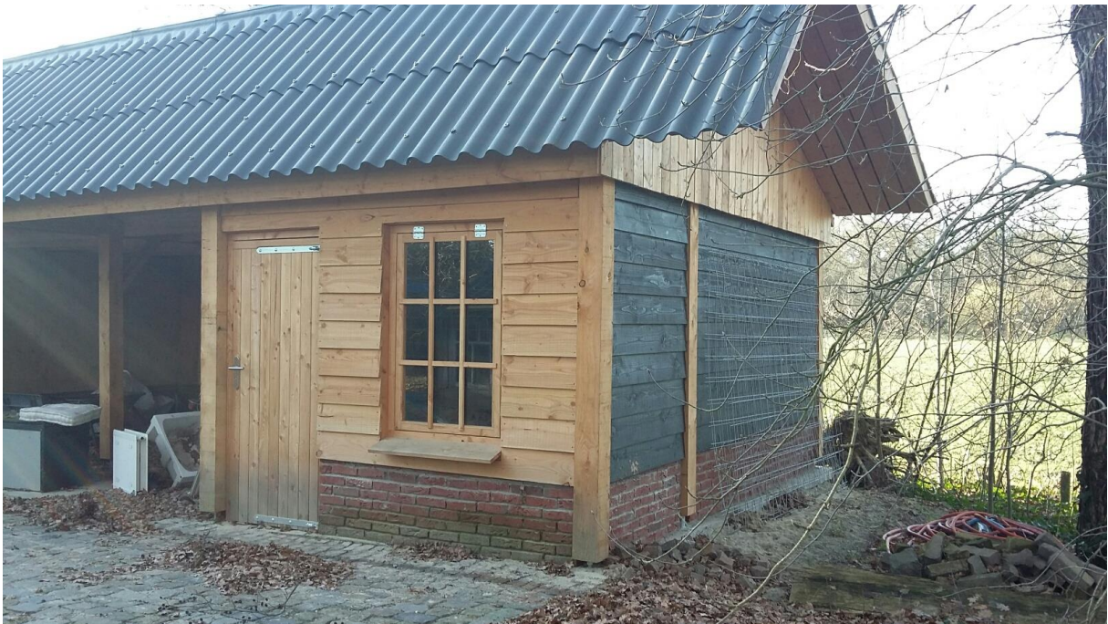
Zijgevel kapschuur achterzijde
