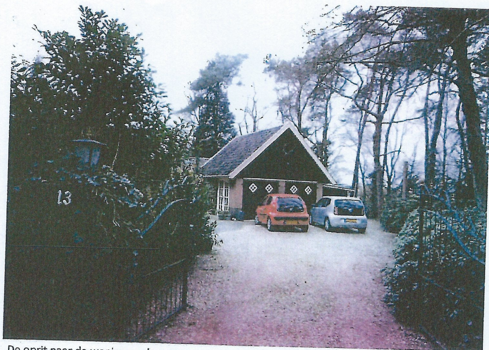
De oprit naar de woning en de garage
