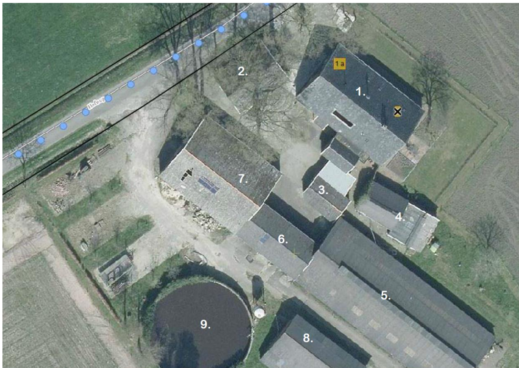
Figuur 1: 1. Bedrijfswoning met inwoning. 2. varkensschuur. 3. Garage. 4. Berging 5. Ligboxstal. 6. Loods/opslag. 7. Loods/opslag. 8. Loods/jongveestal. 9. Mestsilo.
