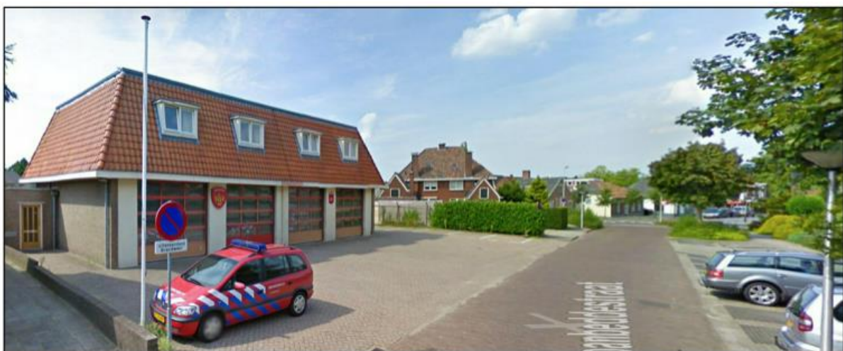
Afbeelding 2.3 Aanzicht huidige situatie plangebied vanuit zuidelijke richting (Bron: Google Street view)
