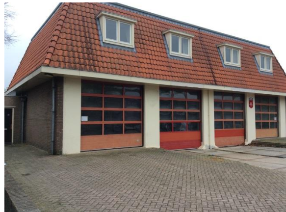
Figuur 9: Overzichtsfoto bebouwing
