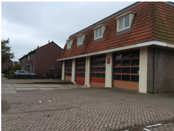
Figuur 8: Overzichtsfoto bebouwing
