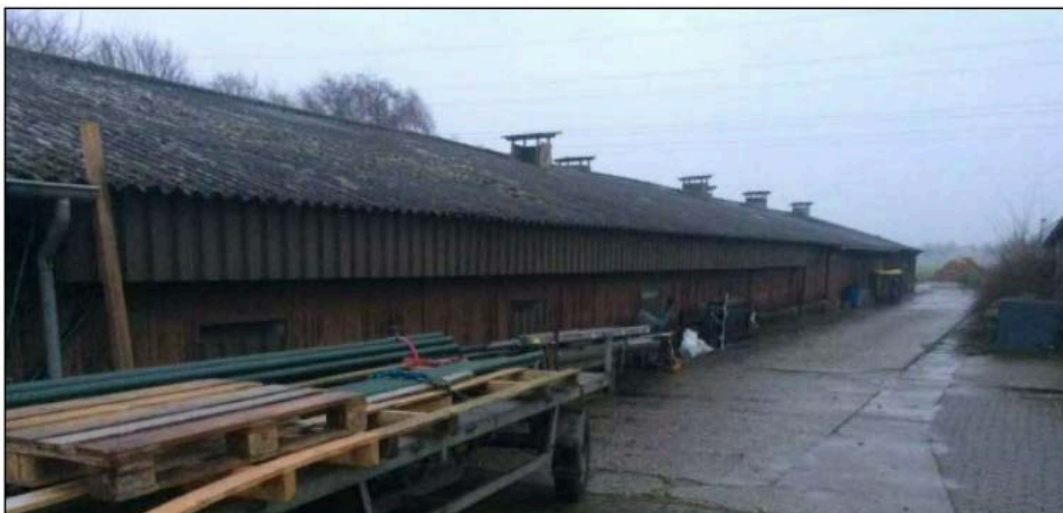
Figuur 2.8 Een van de te slopen schuren (Bron: Borgerink)
