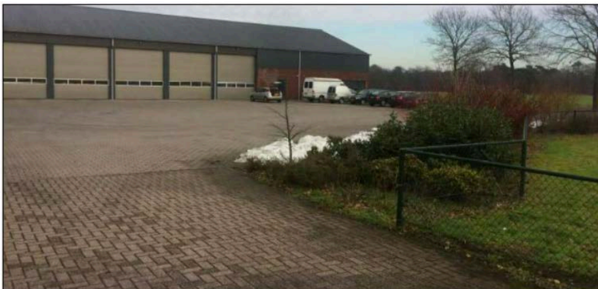
Figuur 2.4 Bestaande werktuigenloods locatie Kolleweg 7 (Bron: Borgerink)
