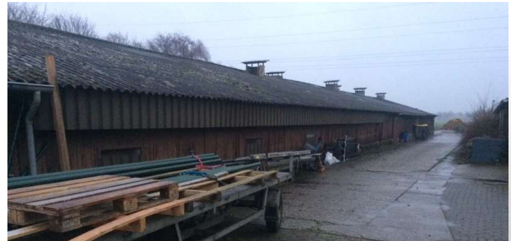
Figuur 14. Foto van de te slopen schuur.
