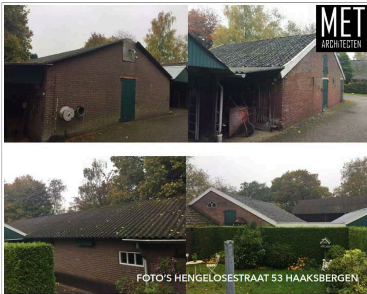
Figuur 2.6 Huidige situatie locatie Hengelosestraat 53 (Bron: MET architecten en Google Maps)
