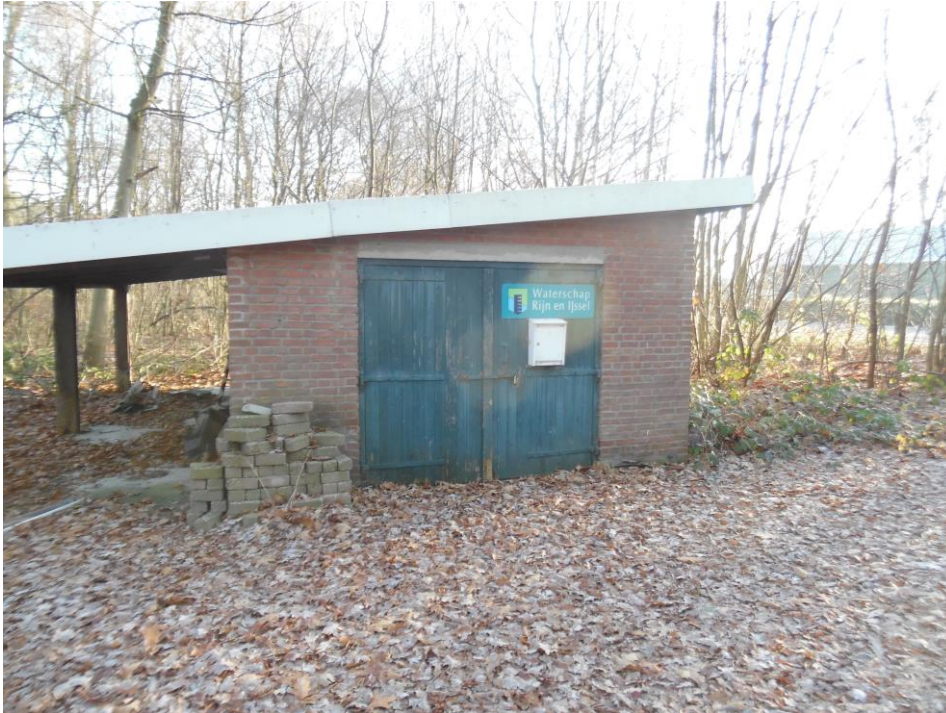
Te slopen gebouw voorzien van golfplaten dak en steens muren
