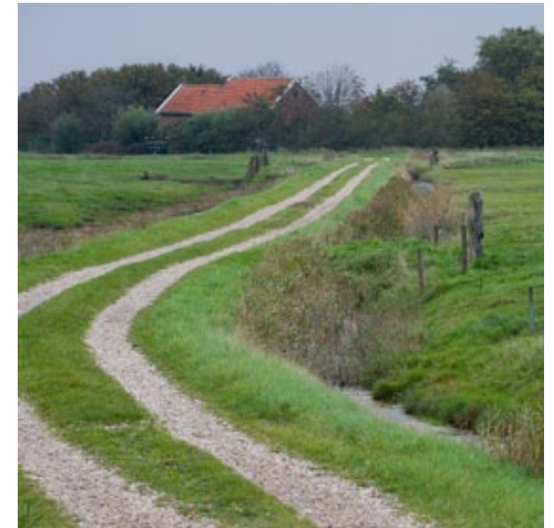
Karrespoor van klinkers of halfverharding (pad oostzijde erf).
