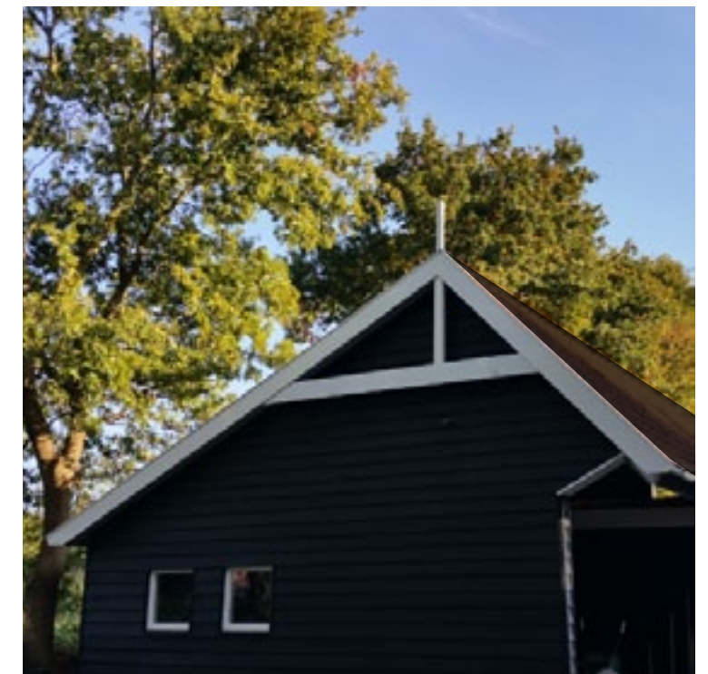
Veldschuur met gepotdekselde houten delen en antraciete pannendak.
