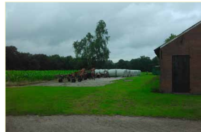
Afbeelding: De te slopen schuur en te verwijderen kuilplaten
