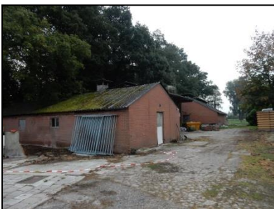
Figuur 6. Te slopen varkensschuur.
