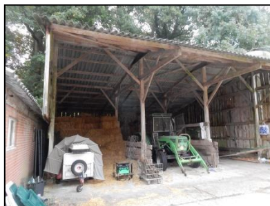
Figuur 7. Te slopen kapschuur.
