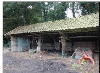
Figuur 8. Te slopen kapschuur.
