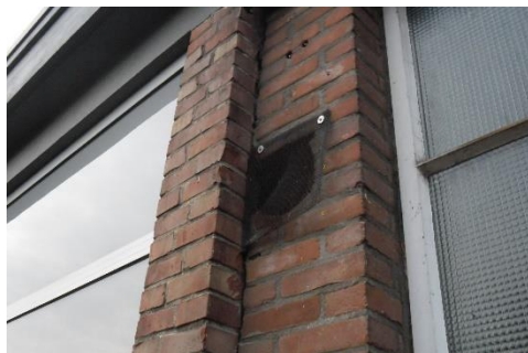
Afb 11. Ventilatiooster met afdekgaas
