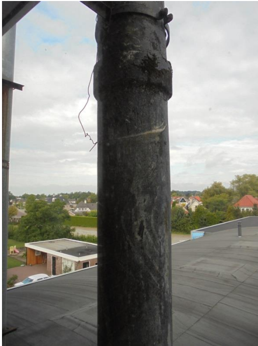
Foto 03: Onderste deel ontluchtingsbuis
