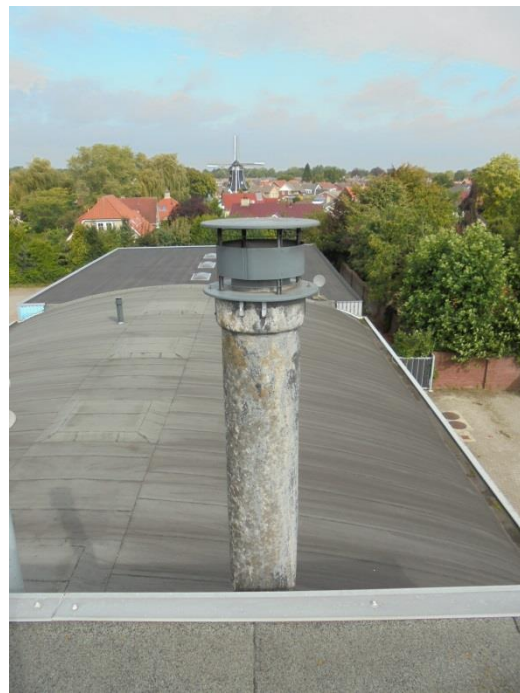
Foto 04: buis gezien vanaf dak bovenwoningen
