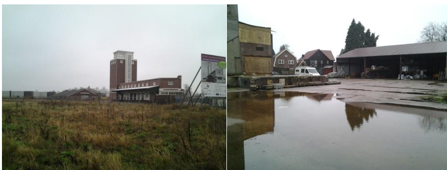
Figuur 4.2 Zicht op het plangebied vanaf boring 5 in noordoostelijke richting (voormalige timmerfabriek en het voormalige gebouw van de landbouwcoöperatie CLV en rechts de achterzijde van de Goorsestraat 2, de Welkoop vanuit het noordoosten in zuidwestelijke richting.
