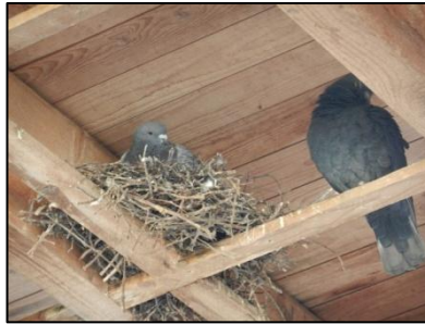
Figuur 16. Broedende stadsduiven.
