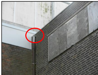
Figuur 8. Detailopname verblijfplaats rond regenpijp.
