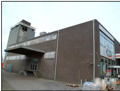
Figuur 2. Westzijde bebouwing.
