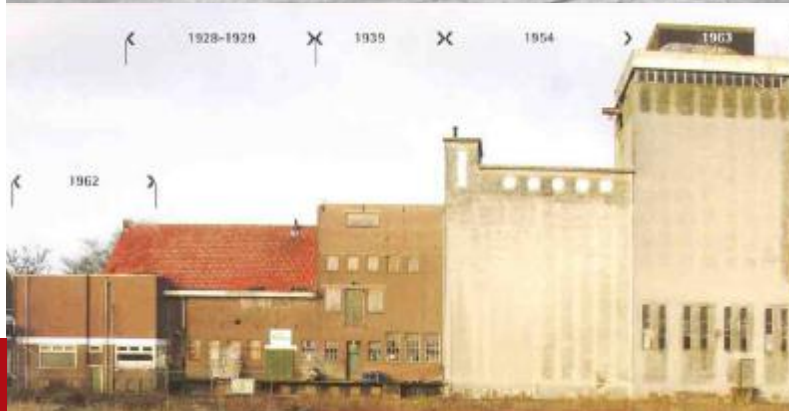
de verschillende bouwfasen van het C.A.V.V. gebouw
