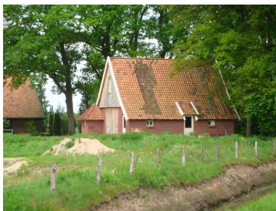
Figuur 8: oostgevel gebouwde veldschuur
