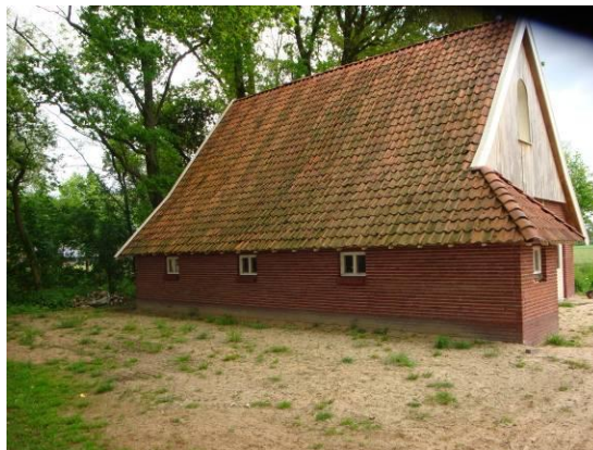
Figuur 7: westgevel gebouwde veldschuur
