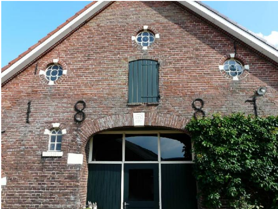
Foto 1, de karakteristieke elementen worden in stand gehouden. Alleen de deuren worden van glas. De stenen en kleine ramen worden in stand gelaten. Dit geldt ook voor de muurankers met het jaartal 1887.
