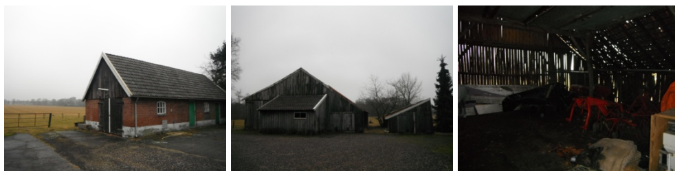
Foto's: Indrukken plangebied. De te slopen opstallen 2, 4 en 5.
