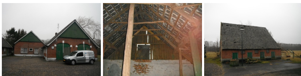
Foto's: Indrukken plangebied. De te renoveren/ vernieuwbouwen opstallen 1 en 3.
