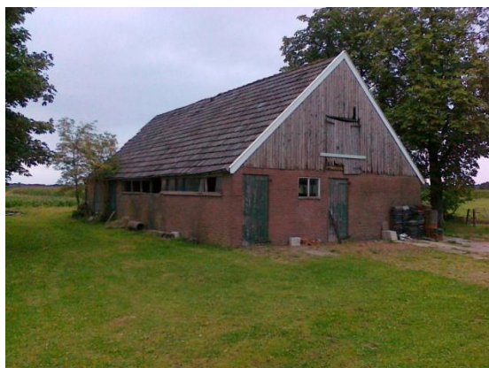
Afbeelding 1: de aanwezige bestaande schuur
