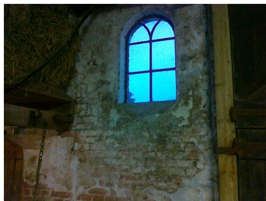
Afbeelding 3: enkelwandige muren zonder spouwmuur
