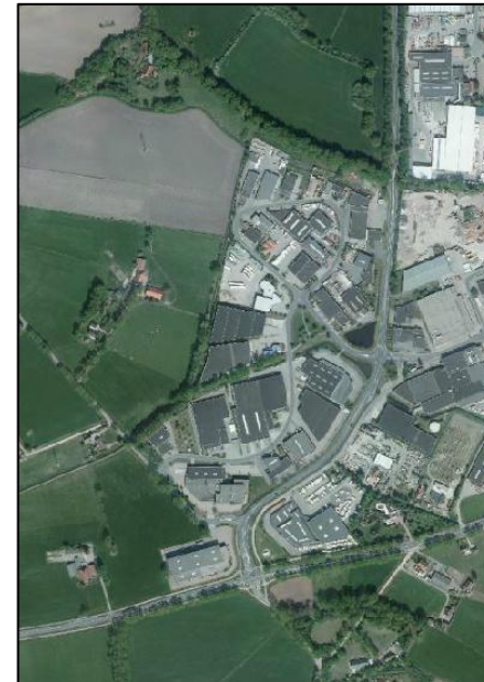
Figuur 13 Harde bebouwingsgrens Haaksbergen verzacht door groenstructuur
