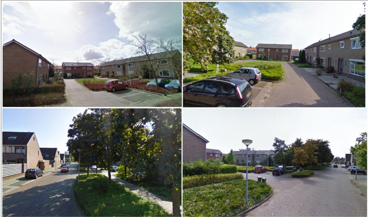
Figuur 2.3: Zicht op het plangebied en de reeds gesloopte woningen vanuit verschillende hoeken (Bron: Google Streetview)
